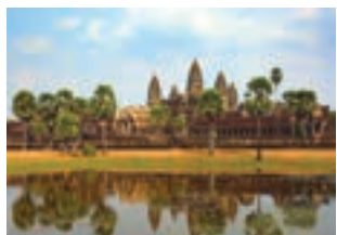
Лемурия. Строительство мегакаменных зданий
