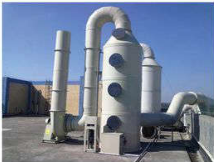
Рис. 27. Скруббер для очистки воздуха
