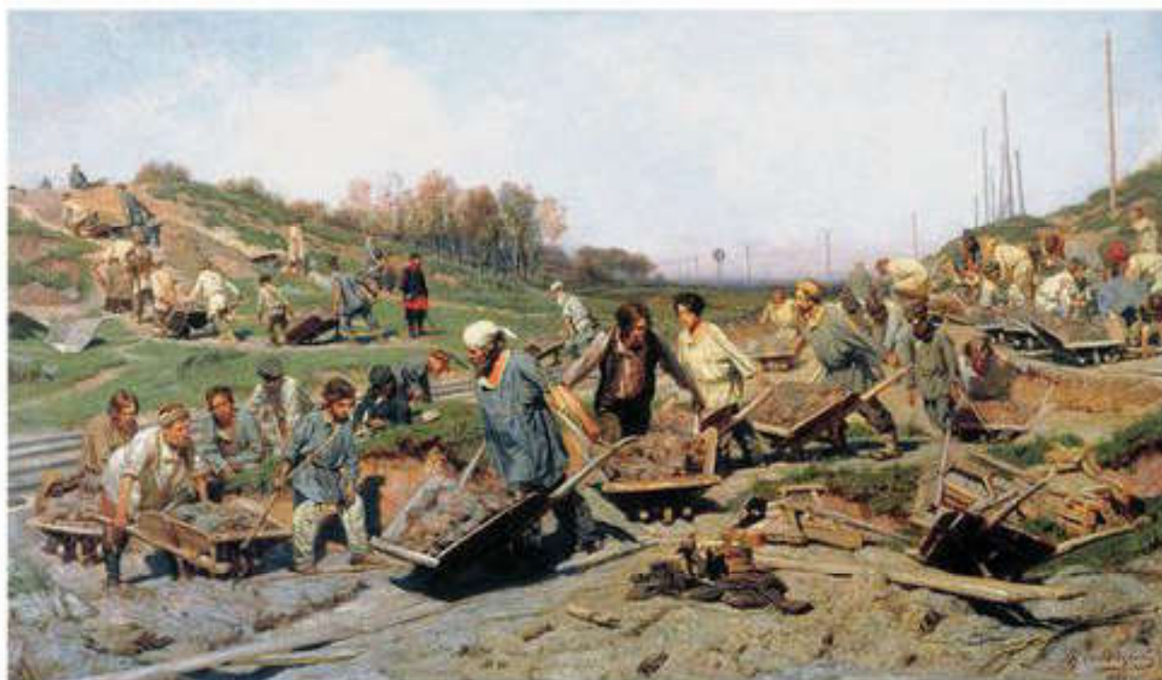
Ремонтные работы на железной дороге
