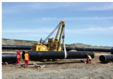
Рабочие прокладывают нефтепровод
