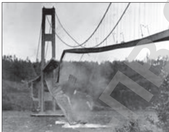
Рис. 160. Разрушение Такомакского моста в Америке, 1940 г.
