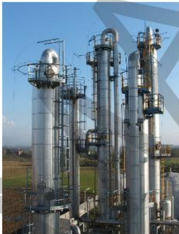
Рис. 116. Трубчатая печь и ректификационная колонна
