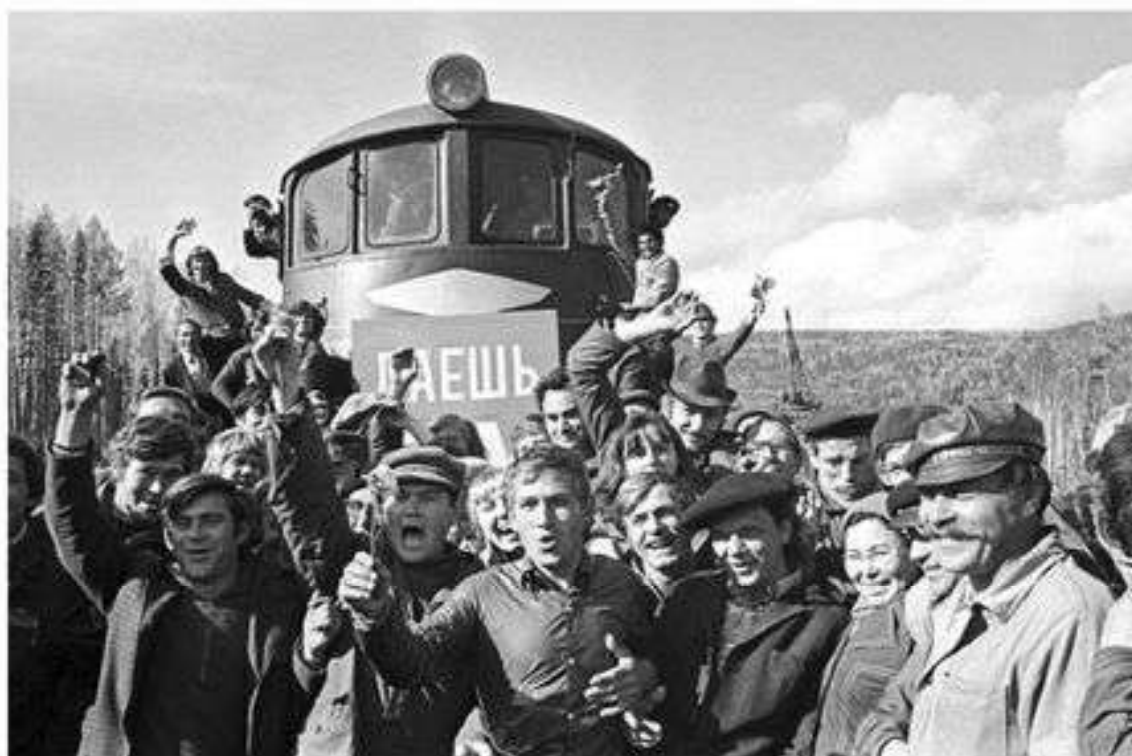
Строительство БАМа, 1975 г.
