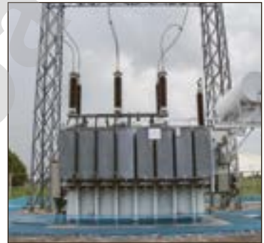
253-сурет. Қосалқы стансыдағы күш трансформаторы
