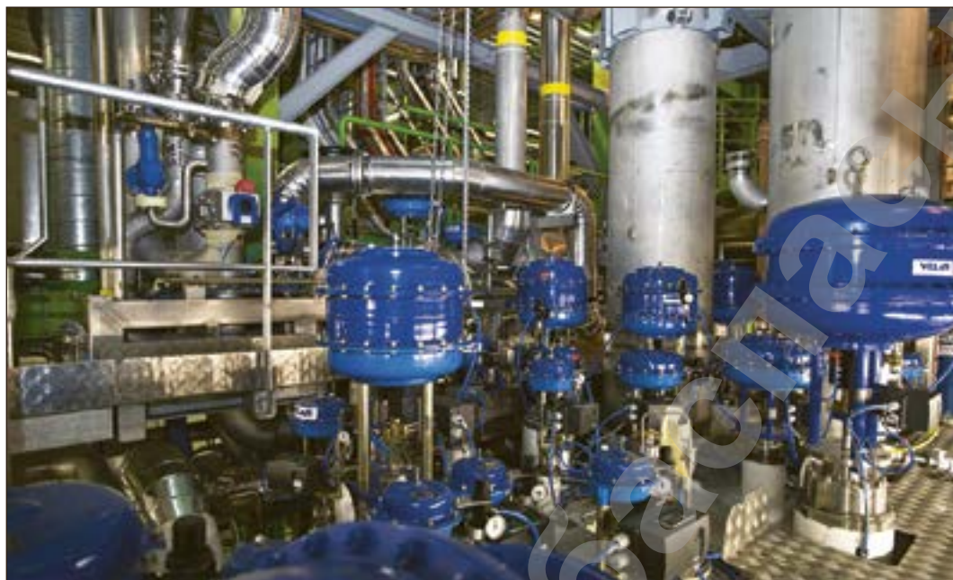
187-сурет. УАК криогенді жүйесінің сұйық гелий үшін қажет – 271,25 °С температураны ұстап тұратын бөлігі
