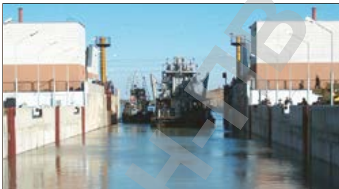
60-сурет. ШҚО Ертіс өзеніндегі Шүлбі ГЭС-інің біркамералы шлюзі
