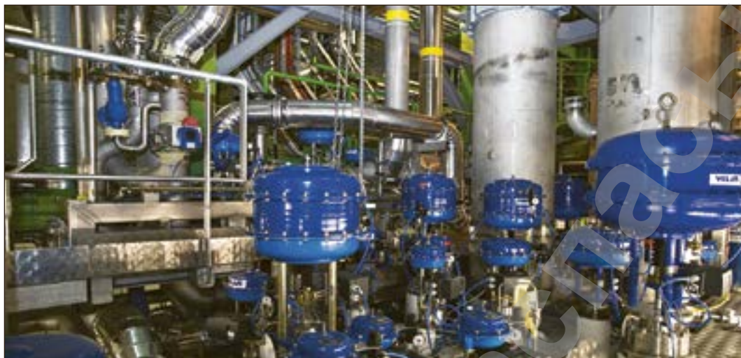
Рис. 187. Часть криогенной системы БАК для поддержания температуры -271,25^{\circ}\text{C} , необходимой для супержидкого гелия
