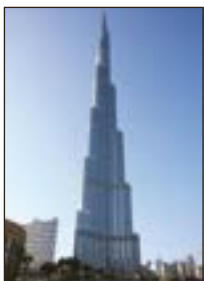
Рис. 40. Небоскреб в Дубае, высота 828 м, 163 этажа
