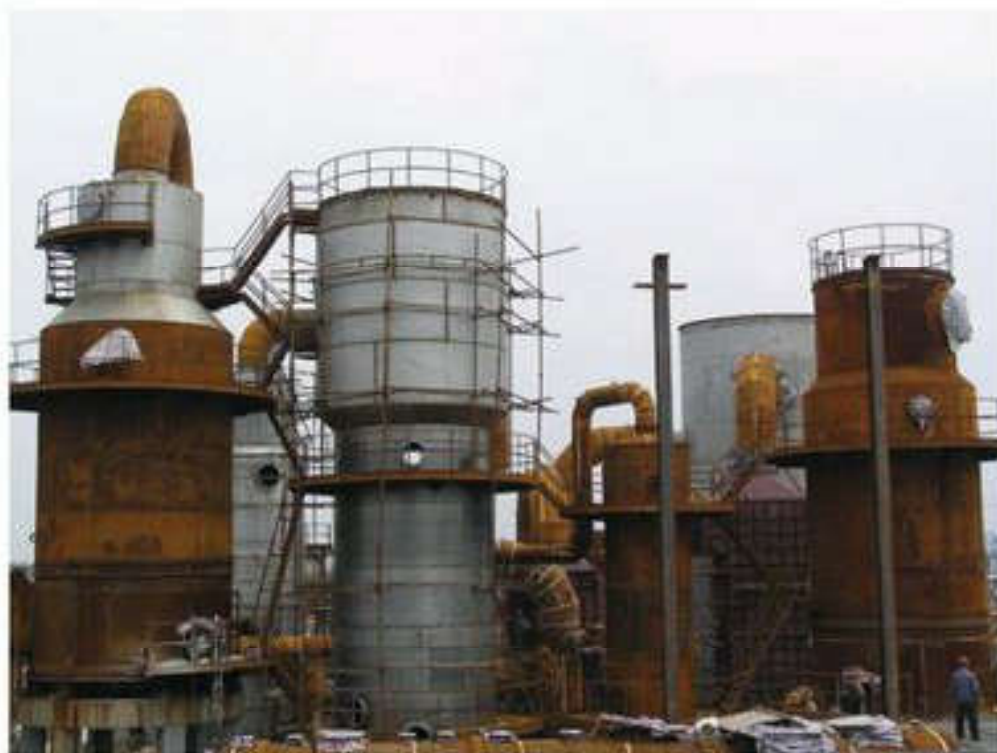
Рис. 137. Завод по производству серной кислоты
