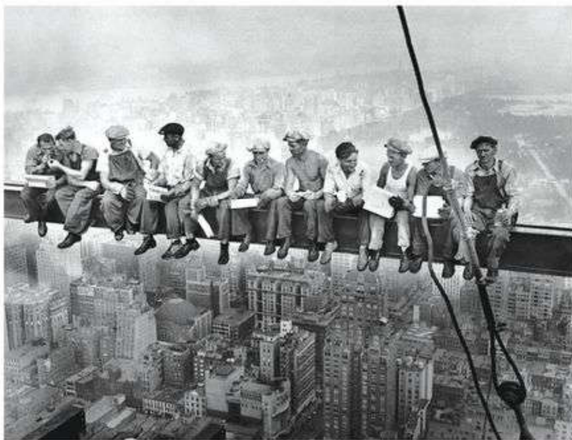
Обед рабочих на небоскребе. Фото 1932 г.
