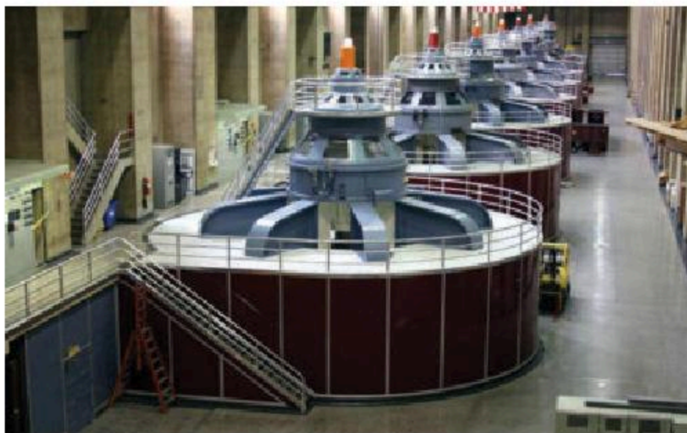
5.1-сурет. ГЭС-те орнатылатын генераторлар
