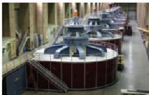
Рис. 5.1. Генераторы на ГЭС
