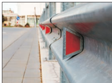
151-сурет. Еуропалық үлгідегі катафоттар мен сигнал бағаналары
