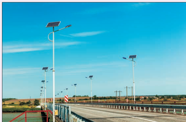
21-сурет. Күн батареялары бар көше шамдары
