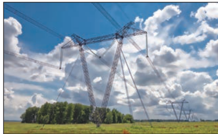
Рис. 45. ЛЭП «Екибастуз – Кокшетау» с проектным напряжением 1150 кВ
